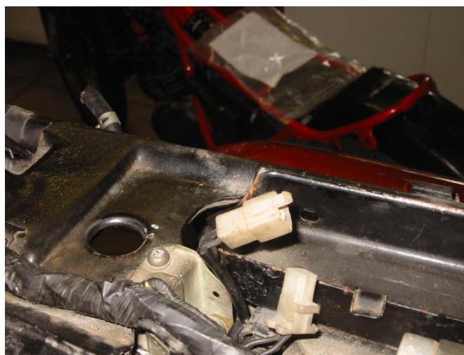
Le connecteur des condensateurs est débranché
